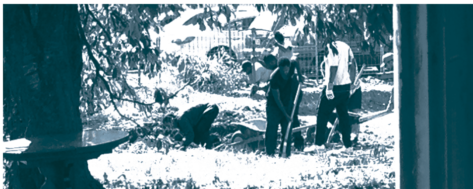
Travaux d'occupation au centre test de Zurich.
