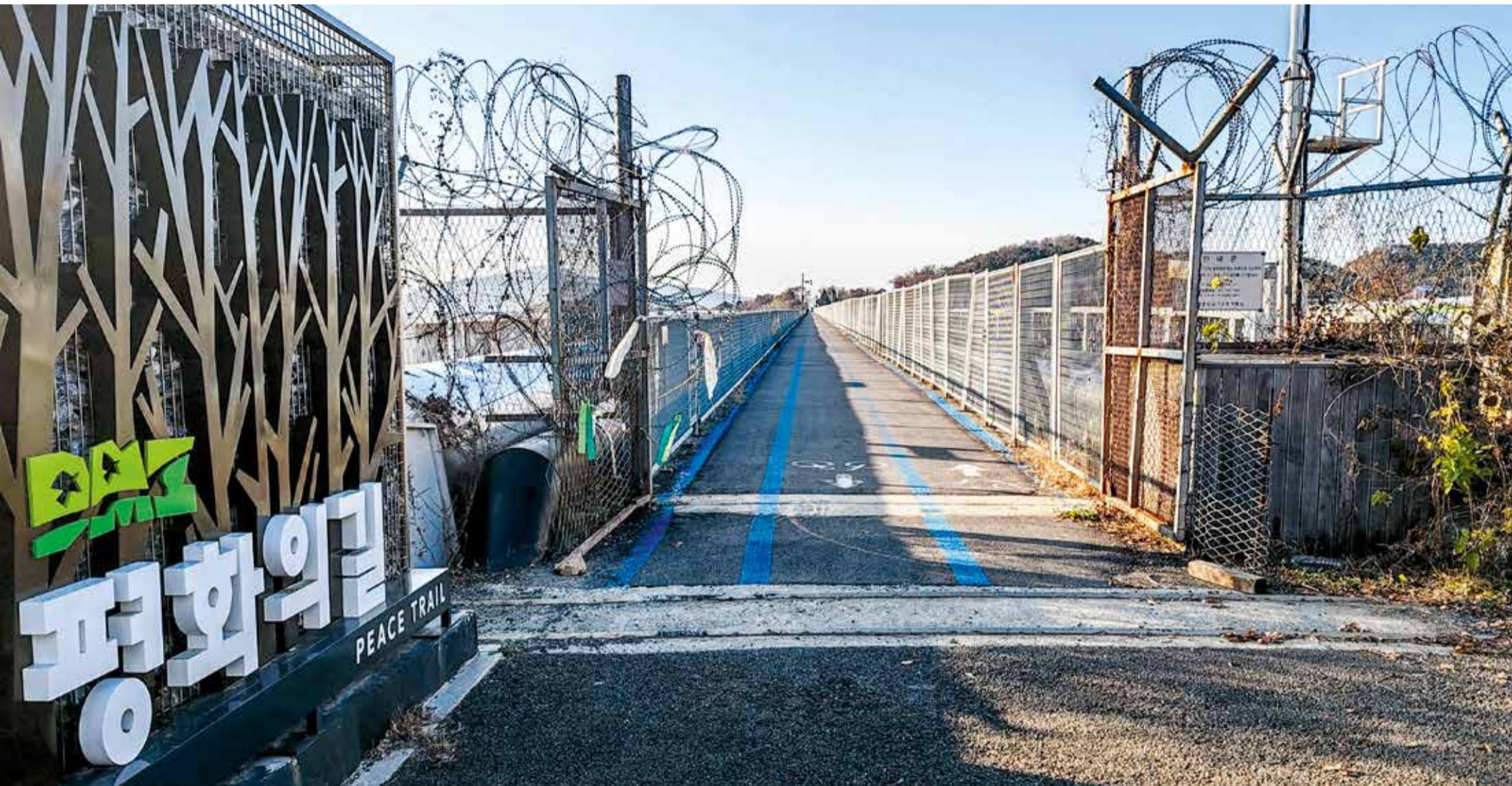
L'ancien pont de Ganghwa, construit en 1969 pour remplacer les bacs d'accès à l'île, est désormais réservé aux cyclistes et aux piétons. Un nouveau pont routier a été édifié en 1997.
